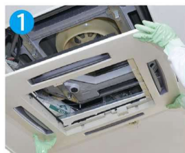
外装パネルの取り外し
