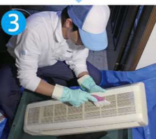
外装パネルのクリーニング
